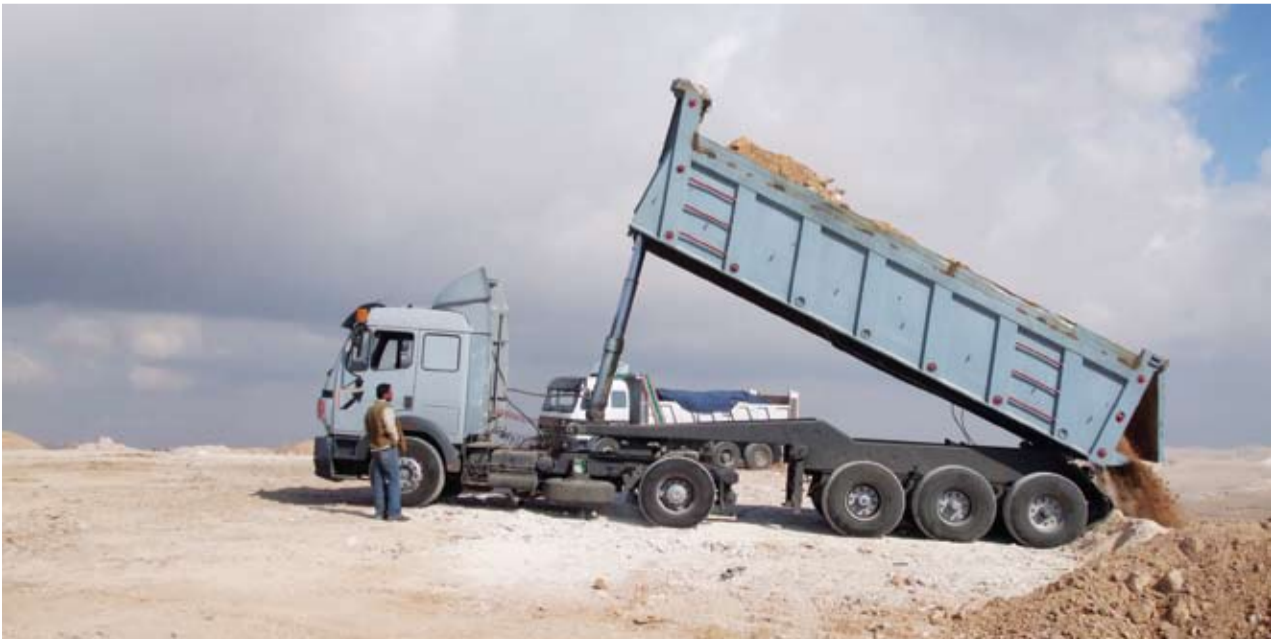
تنظيم عملية طرح الطمم والأنقاض
